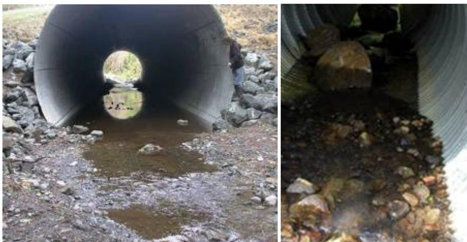
Рис. 7.9 (а, б, в). Кульверт, частично заглубленный в грунт ниже отметки дна ручья (Planning..., 2009; Hydraulic..., 2007; Oregon ..., 2003).
