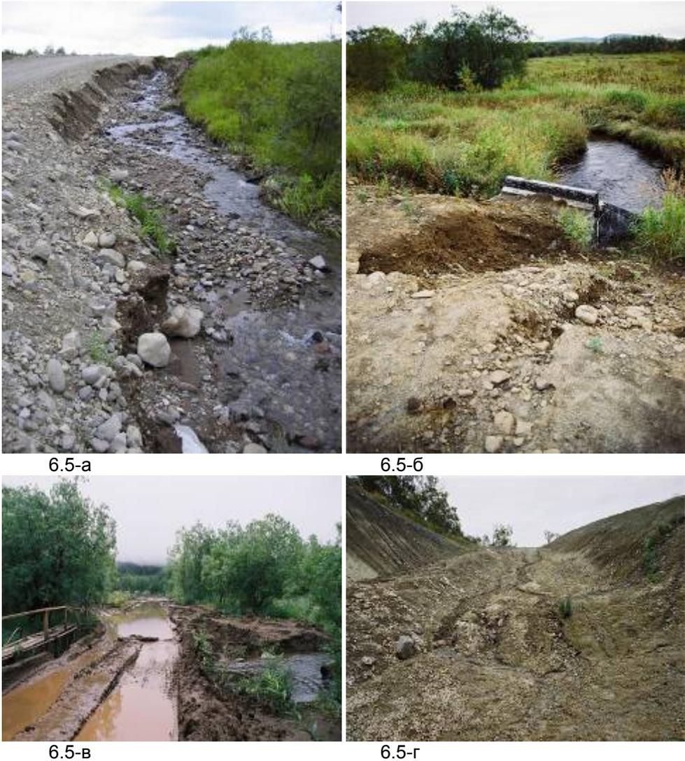
Рис. 6.5. Отсутствие противоэрозионных мероприятий:
