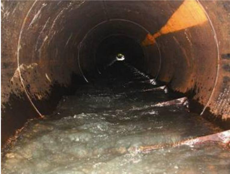
Рис. 7.14-а. Кульверт круглого сечения с внутренними перегородками — гасителями течения и рассекателями потока. Косые перегородки, идущие под углом к потоку, с уменьшающейся высотой, обеспечивают свободный проход молоди лососевых рыб. Между перегородками видны зоны отдыха для рыб (Hydraulic..., 2007).
