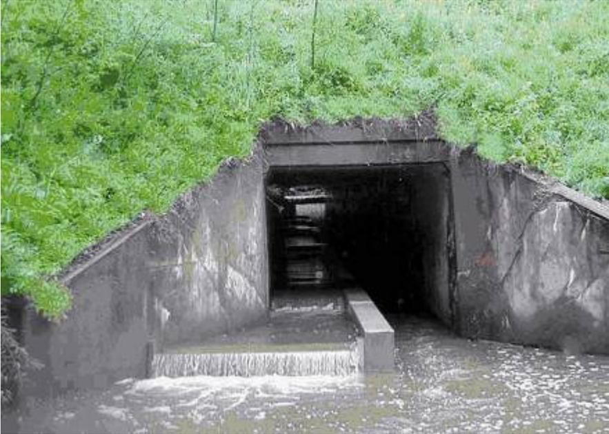
Рис. 7.14-в. Кульверт с лестничным рыбоходом (Hydraulic..., 2007).
