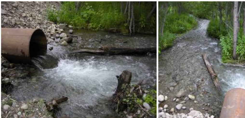
Рис. 7.7 (а, б). Ошибочная установка кульверта (протока р. Левая Самка, р. Ича, Западная Камчатка).
