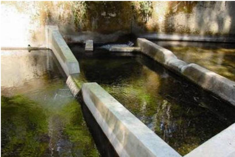
Рис. 7.14-б. Кульверт с каскадом подпорных дамб (Hydraulic..., 2007). Главная особенность - ступенчатое повышение уровня воды и центральные пороги для пропуска рыбы.
